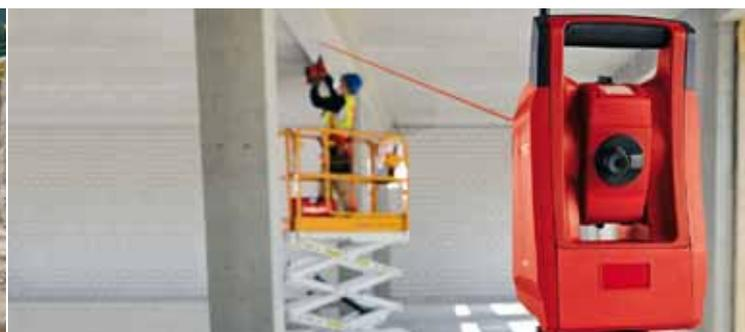
Befestigungspunkte mit dem Laserpunkt direkt an Wänden und Decken markieren.
