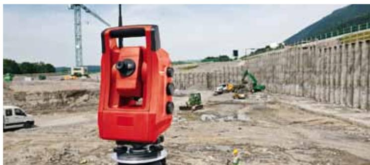
Abstecken und Aufmass der Baugrube für den Aushub des Fundaments.
