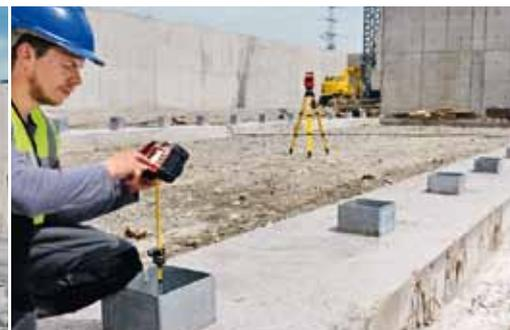
Achsabsteckungen auf der Bauachse. Millimetergenau und schnell.
