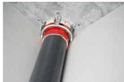
**Descrizione:** Tubazioni montate direttamente in angolo con distanza zero da due elementi costruttivi a supporto rigido.
