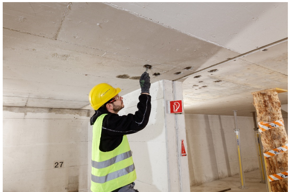
Abb. 28 Montage des HZA-P-Ankers
