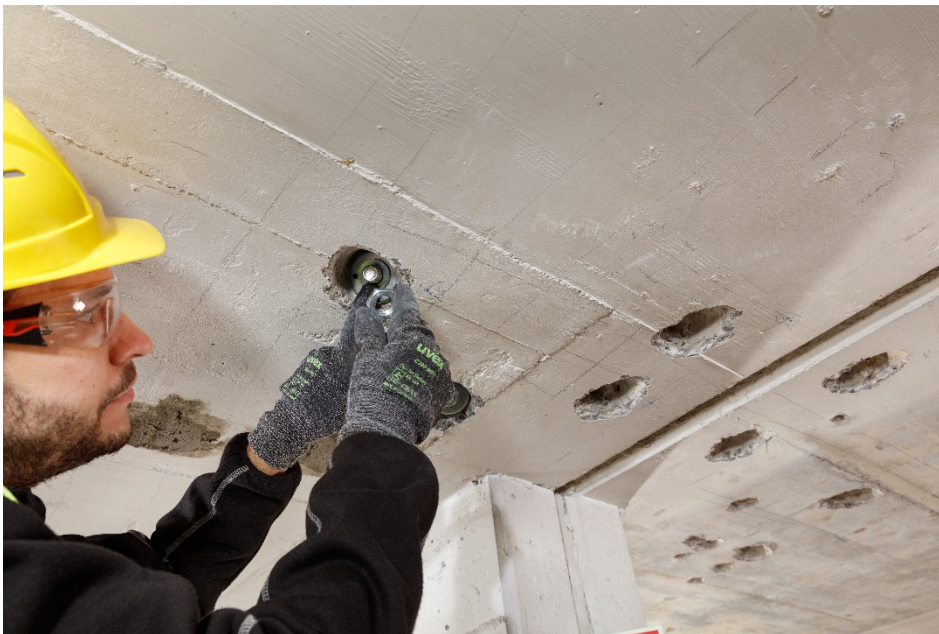
Abb. 29 Montage des Ankerkopfes
