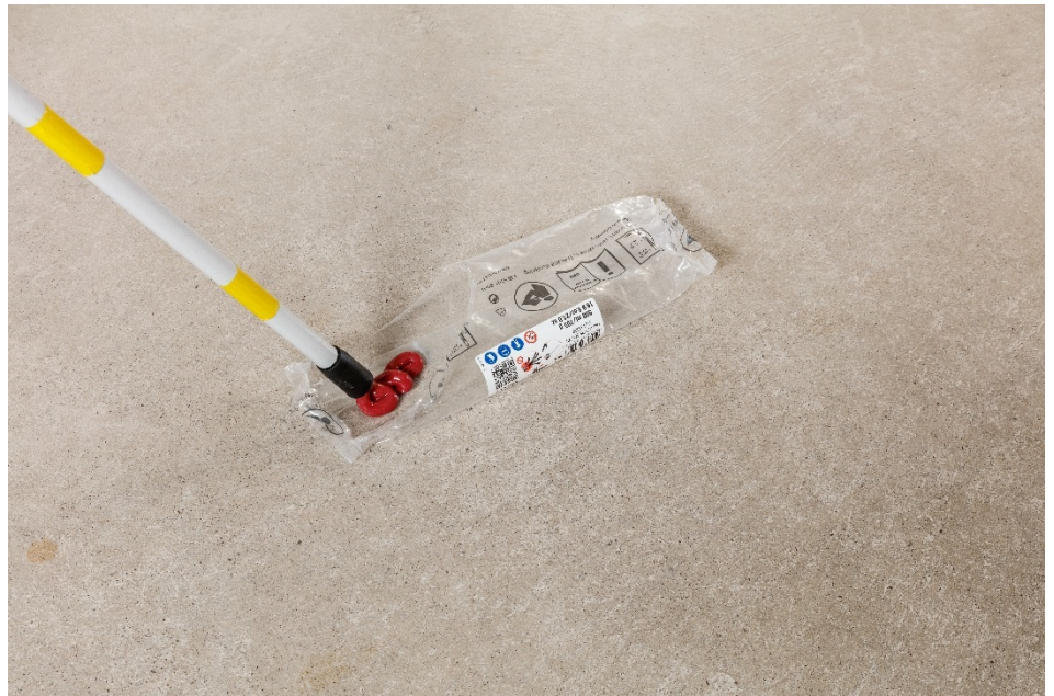
Abb. 25 Verwerfen der anfänglichen Mörtelmenge
