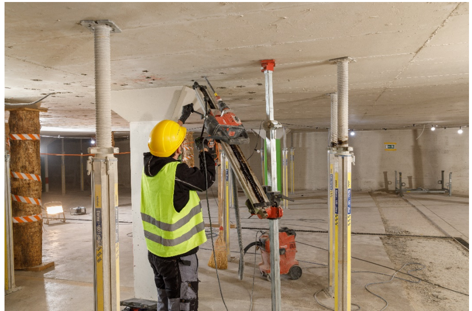
Abb. 20 Bohren mit Spezialbohrständer und Hohlbohrer zur automatischen Bohrlochreinigung
