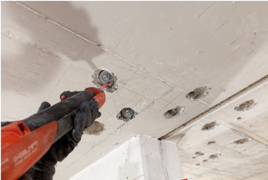
Abb. 33 Injektion von Mörtel in Unterlegscheibe
