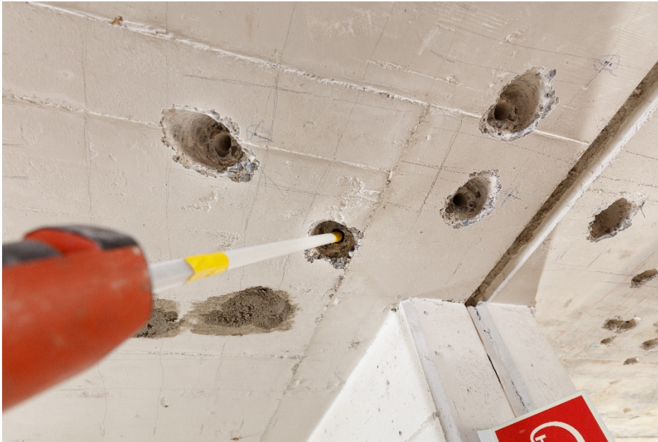
Abb. 26 Injektion von Mörtel (Startposition)
