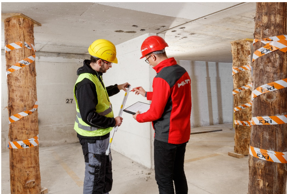
Abb. 24 Vorbereitung der Verlängerung Hit-VL
