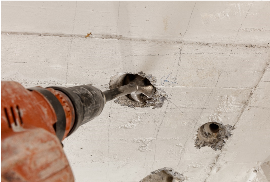
Abb. 22 Verbreiterung des Bohrlochs mit Spezialbohrer TE-Y-GB
