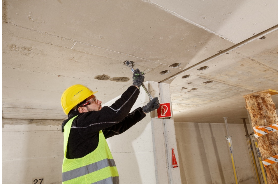
Abb. 30 Anwendung des Drehmoments
