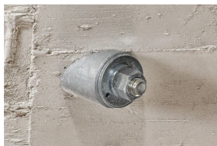
Abb. 9: Externer Ankerkopf
