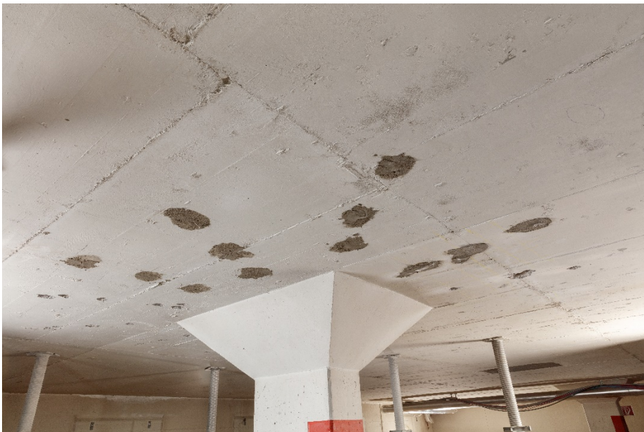
Abb. 34 Abschließende Füllung mit Brandschutzmörtel
