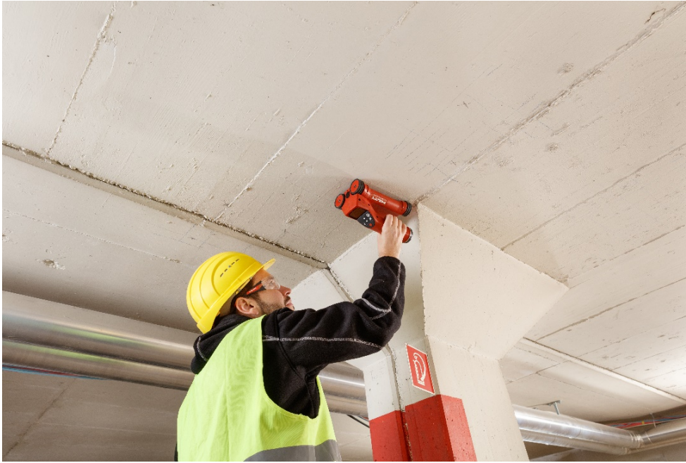
Abb. 19 Lage der Bewehrung mit Ferrosan PS 200
