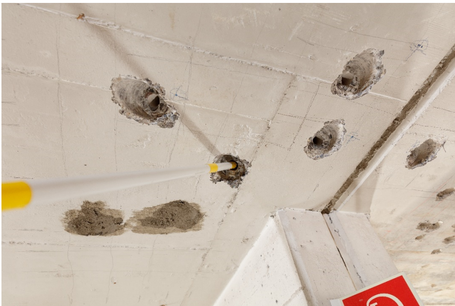
Abb. 27 Injektion von Mörtel (Endposition)
