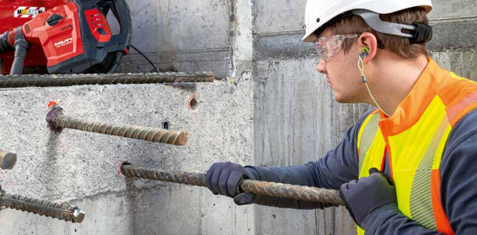
L'obbligo di realizzare una connessione in cemento armato momento-resistente mediante giunto di sovrapposizione può avere conseguenze di rilievo per la procedura dei lavori, per la loro economicità e per la protezione sul lavoro:
