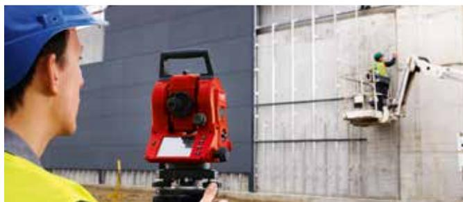
Relevé des cotes des anciens bâtiments et fixation des points d'ancrage. Le tachymètre Hilti vous guide pas à pas avec des tâches de mesure préprogrammées. Pour une mise en place précise et rapide des profils, Hilti propose une gamme adéquate de lasers rotatifs, par exemple le Hilti PR 30-HVS.
