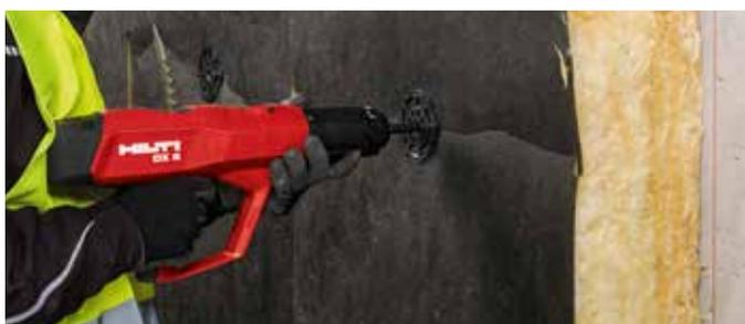
Une isolation thermique jusqu'à une épaisseur de 200 mm peut être fixée facilement dans le béton au moyen d'une fixation directe. La combinaison du cloueur et des fixations d'isolation X-IE est ce qu'il y a de mieux en termes de sécurité et de rapidité. Nous vous proposons bien sûr aussi des solutions avec chevilles et vis adaptées pour la fixation du matériau isolant sur tous les types de matériaux support.
