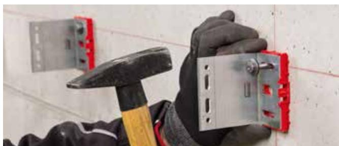
Différents systèmes sont à disposition pour l'ancrage des supports muraux:
