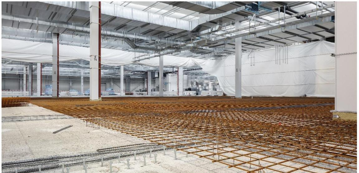
Abbildung 1 Eine typische Anwendung von Aufbeton im Hoch- und Tiefbau ist die Verstärkung oder Instandsetzung von Industriefußboden
