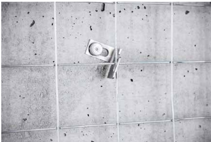
Befestigung von Drahtgeflecht für Brandschutzmörtel
