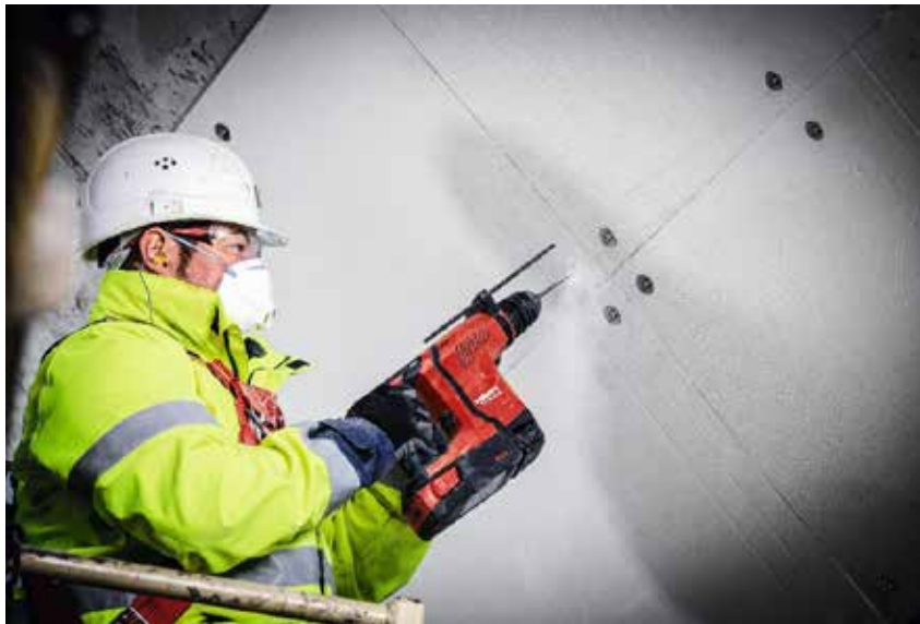
Befestigung von vorgefertigten Brandschutzplatten
