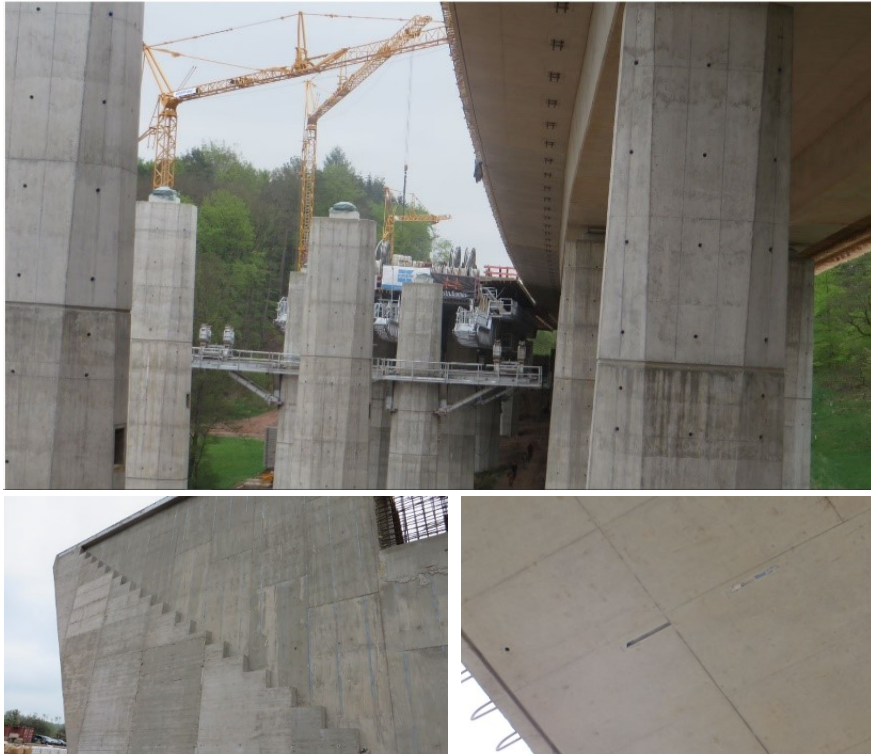
Talbrücke Herleshausen A4
